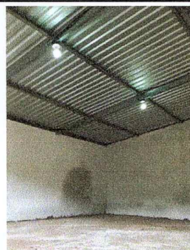
Foto 8: Mejoramiento de pared formal a base de block con su respectivo repello.
