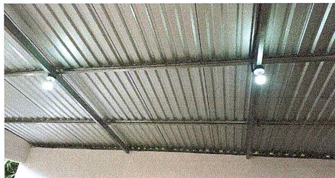
Foto 2: Instalación de estructura de metal para mejorar las condiciones de soporte de cubierta.
