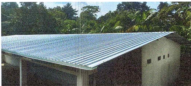
Foto 1: Instalación de cubierta de techo (lámina troquelada aluzinc calibre 26) para mejor vida útil.
